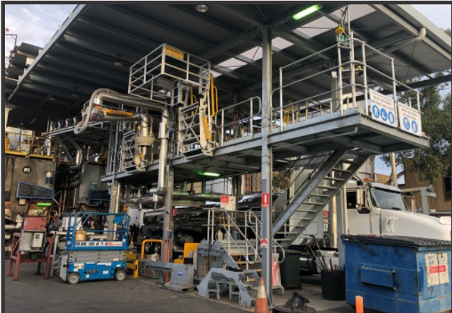
Aplicación de carga de Bitumen en Sydney, Australia
